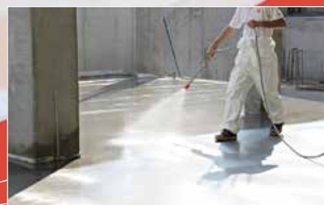
Foto 3 - trattamento pavimentazione in cemento quarzato
