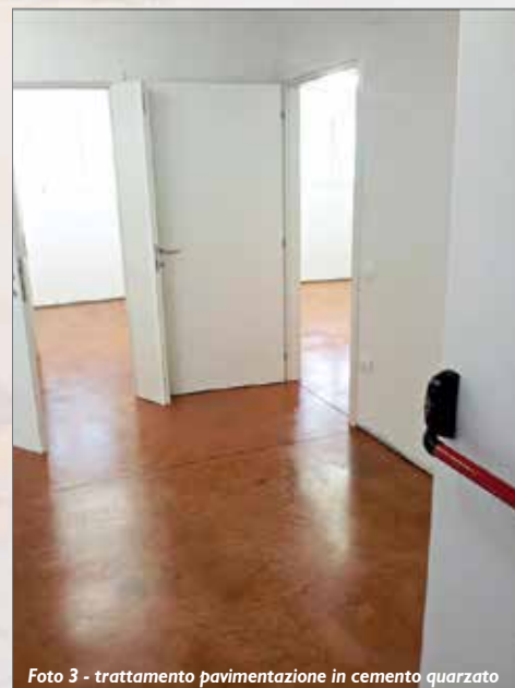
Foto 3 - trattamento pavimentazione in cemento quarzato
